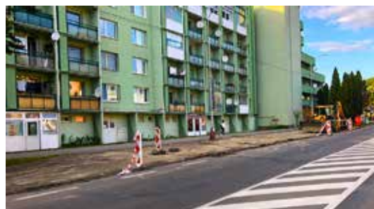
Oprava parkovísk na Ulici duklianských hrdinov
