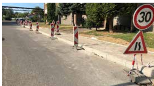
Oprava komunikácií JUH 1048
