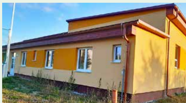
Prístavba pri ZŠ Kukučínova
