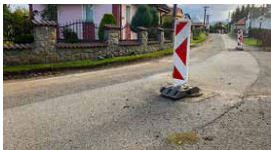
Realizovaná oprava ulice Kpt. Nálepku
