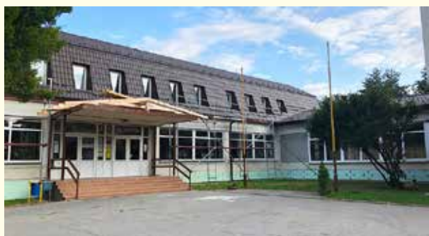
Zateplenie časti budovy ZŠ Bernolákova
