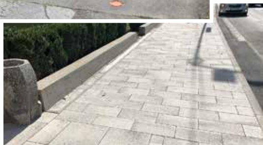
Chodník pri bazilike pred a po oprave
