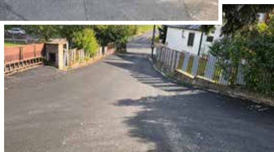
Cesta na Krátkej ulici pred a po oprave
