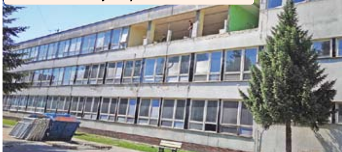
Výmena okenných výplní na budove II. stupňa Základnej školy Bernolákova
