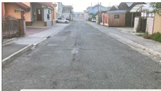
Miestna komunikácia na Bernolákovej ulici pri tržnici
