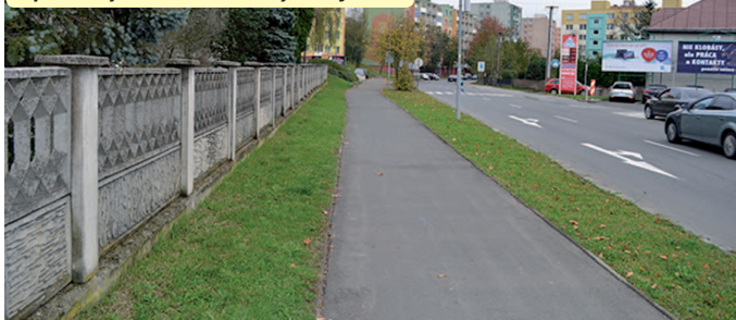
Opravený chodník na Mlynskej ulici
