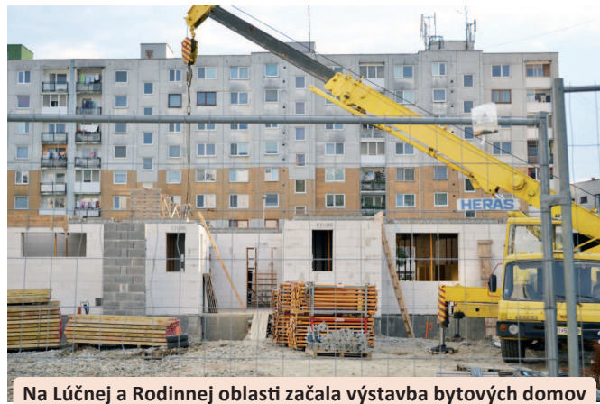
Na Lúčnej a Rodinnej oblasti začala výstavba bytových domov
