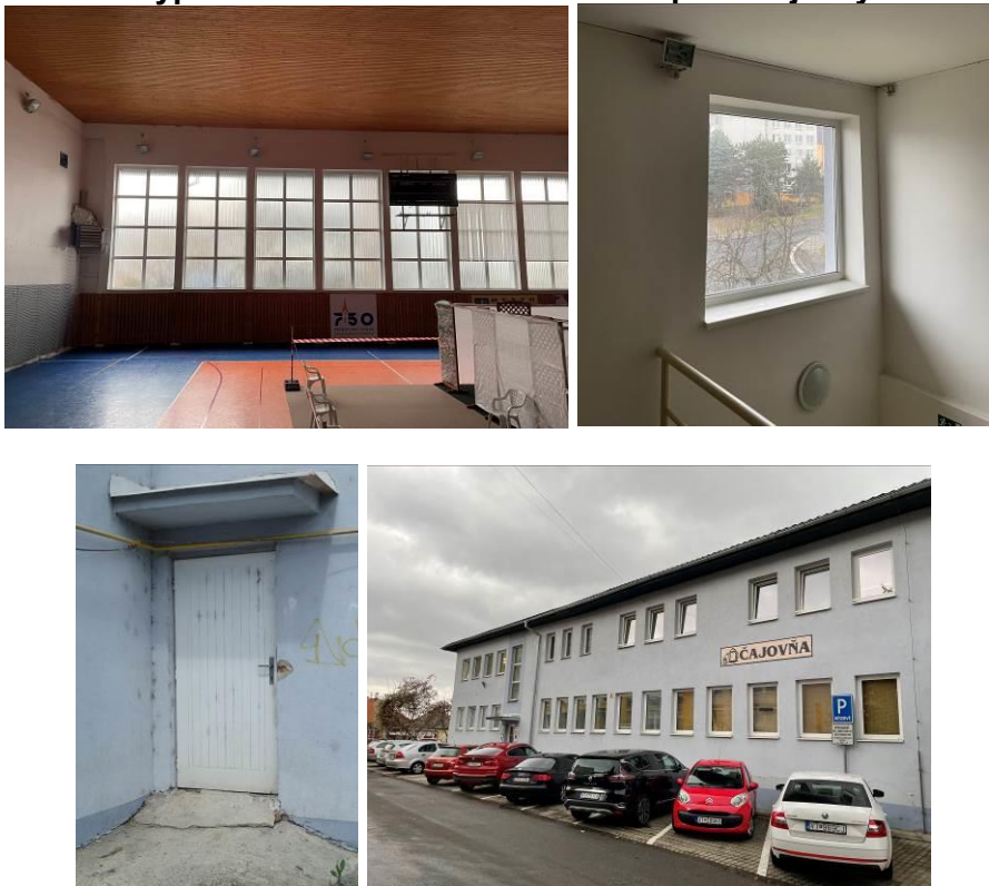
Výplňové konštrukcie na budove športovej haly
